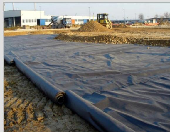
*Geotessili di rinforzo e separazione*
